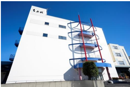
川越本社 第1工場 (川越市芳野台)
